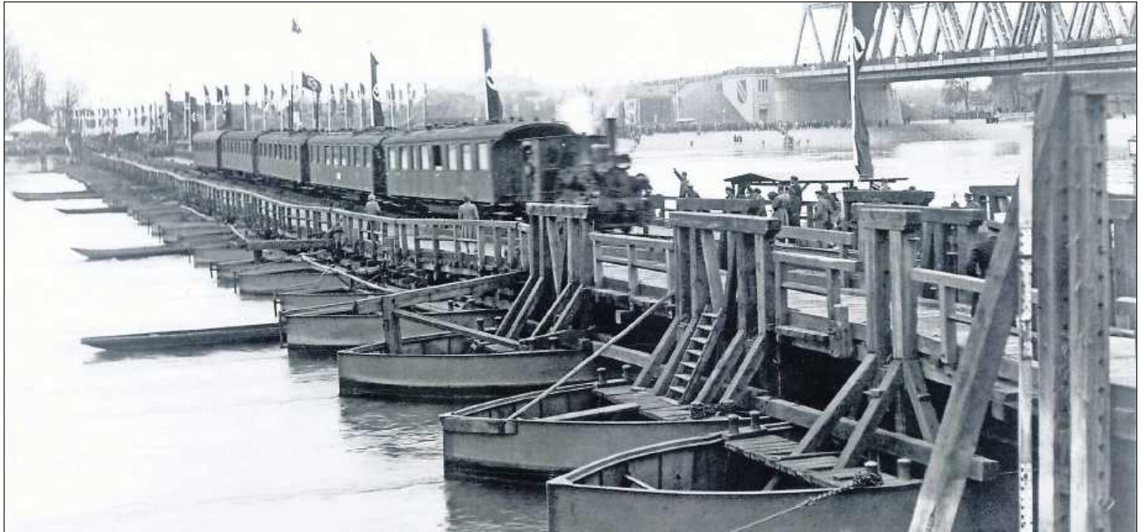
Ein Zug fährt über die schwimmende Eisenbahnbrücke.
